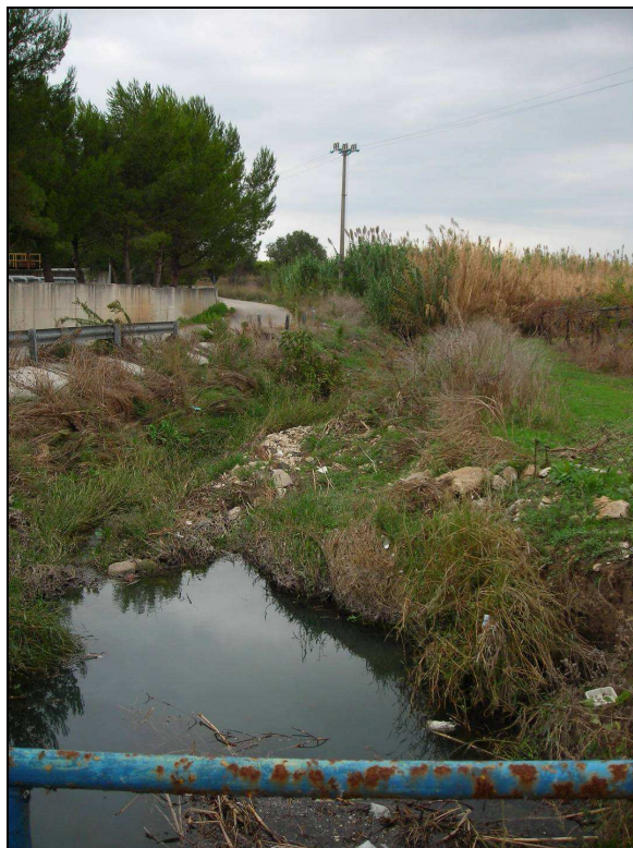
Foto 1: Piccola incisione torrentizia adiacente l'impianto di depurazione.
